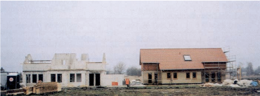
Abb. 3-1: Beide Häuser im Bauzustand
